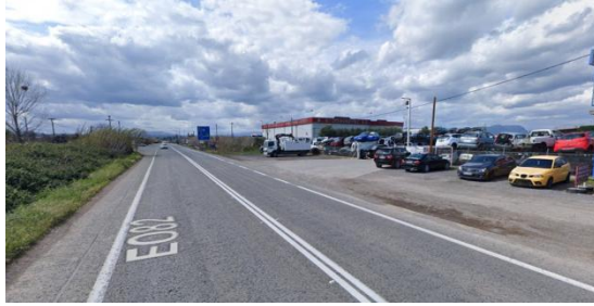
Εικόνα 8: Υφιστάμενη κατάσταση στον οδικό άξονα Μεσσήνη - Ασπρόχωμα (παρόδιες ιδιοκτησίες πλησίον της οδού).
