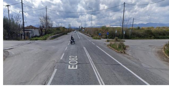
Εικόνα 9: Υφιστάμενη κατάσταση στον οδικό άξονα Μεσσήνη - Ασπρόχωμα (διασταυρώσεις επί της οδού).
