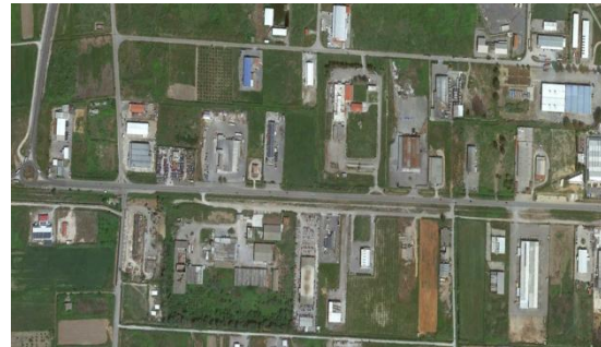
Εικόνα 11: Υφιστάμενη κατάσταση στον οδικό άξονα Μεσσήνη - Ασπρόχωμα (παρόδιες ιδιοκτησίες εκατέρωθεν της οδού - Δορυφορική Λήψη).
