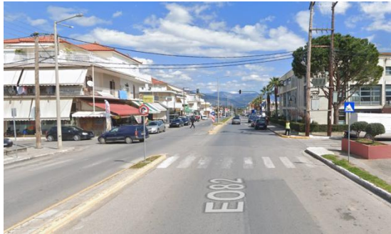
Εικόνα 31: Διάβαση Πεζών επί της Λεωφ. Εθνάρχου Μακαρίου.
